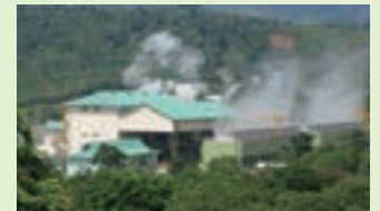
ウルブル地熱発電所
