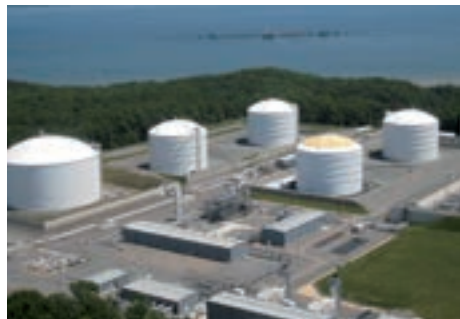
ドミニオンが運営するコーブポイントLNG基地
