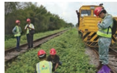
主要幹線であるヤンゴン-バゴー間(約70キロメートル)のうち20キロメートルのパイロット区間で実施予定
