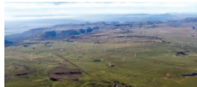
全40基の大型風車の据え付けが完了した南アフリカ初の大規模風力発電所
