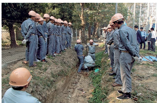
訓練教室では敷地内に実習設備を整備し、配管や送配電の実技指導を行っている
