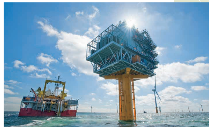
複数の風車から電力を集め、洋上で昇圧を行い陸地へ送電する
