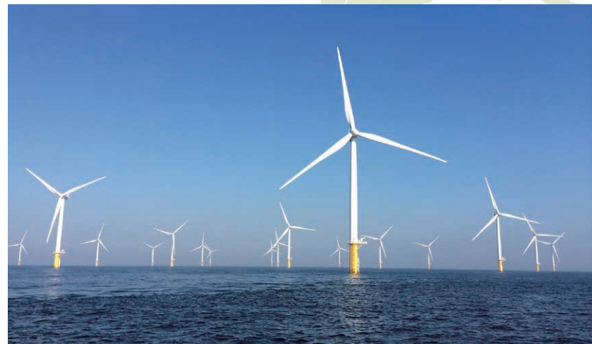
ベルギー沖合は遠浅な地形のため、基礎を直接海底に打ち込めることから洋上風力発電事業に適している
