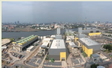
2016年1月に完工したノースバンコック2ガス複合火力発電所(タイ)
