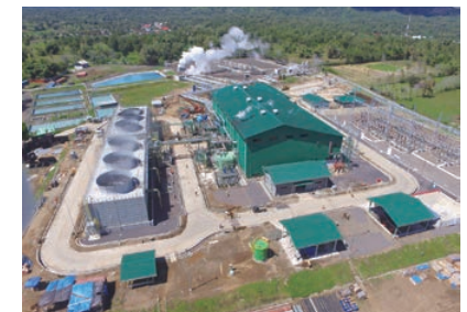
建設中のラヘンドン地熱発電所(インドネシア)
