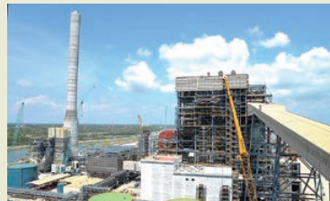
建設中のマンジュン石炭火力発電所。当社受注案件はマレー半島全電源の20パーセント強を賄う予定(マレーシア)
