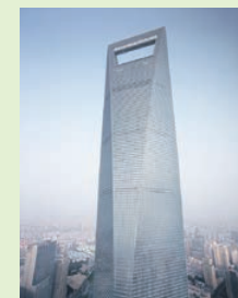
現在の上海住友商事の入居するオフィスビル
