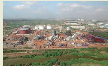
ポーン複合火力発電事業は建設工事を着実に進め、長期安定操作を行うことにより社会問題となっている電力不足の改善を目指す(ガーナ)
