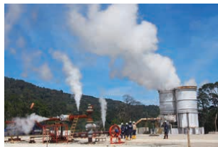
高温の地熱流体から蒸気が噴き出す
