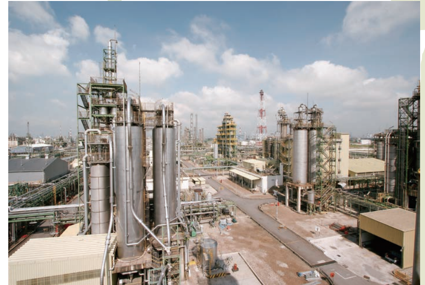
1970年代に造成が始まり、今では石油化学産業の中心となっているジュロン島内の化学プラント
