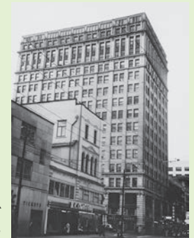
1970年代に事務所が入居していたビル
