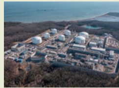
コーブポイントLNG基地 天然ガス液化プラント
