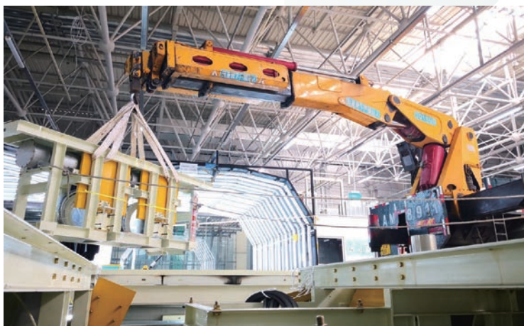
自動車検査設備を据付作業中
