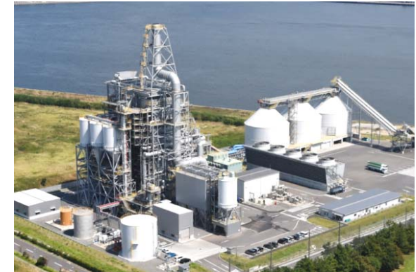
愛知県半田市における バイオマス発電事業
