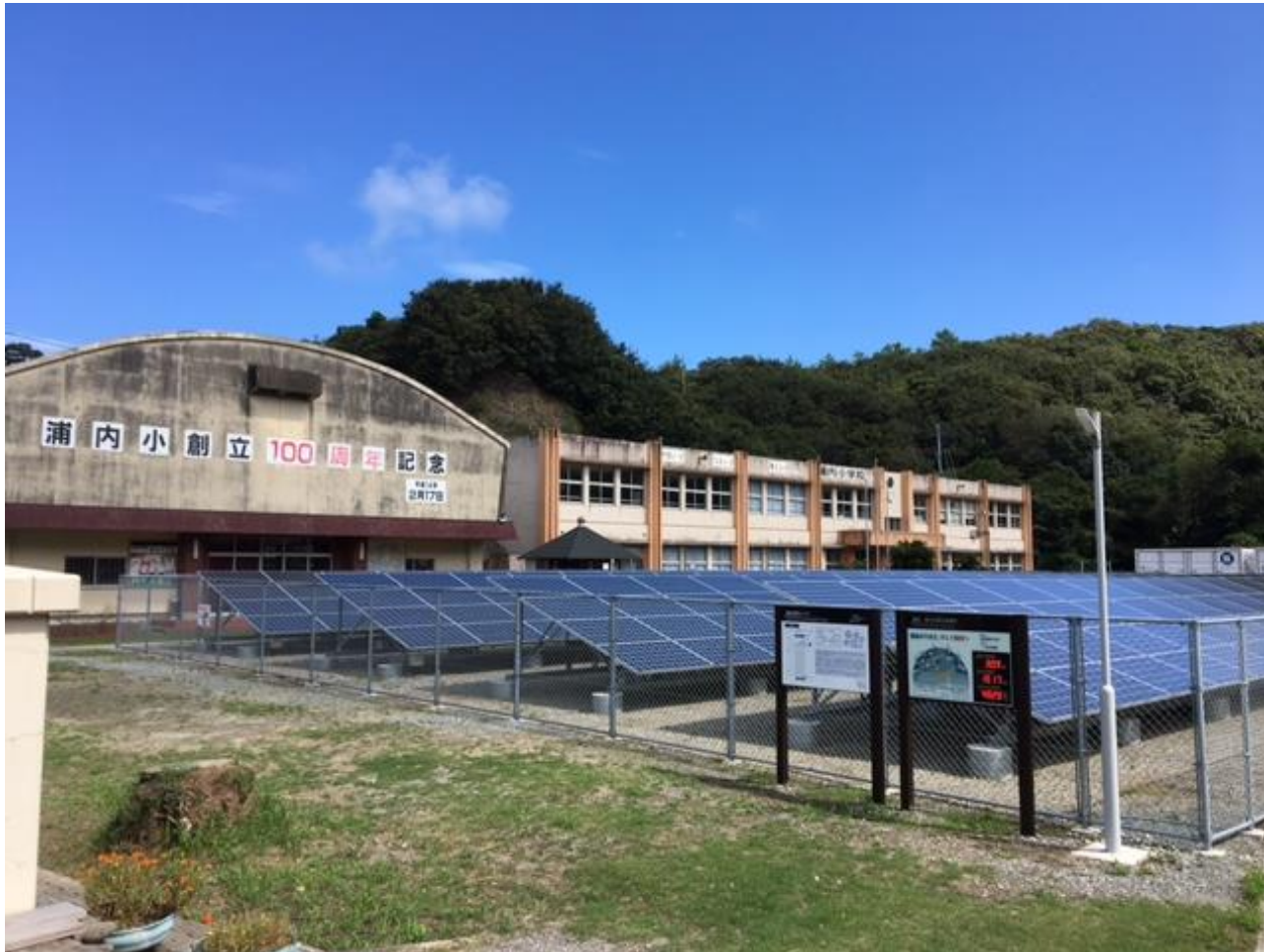
旧浦内小学校を利用した甕島蓄電センター
