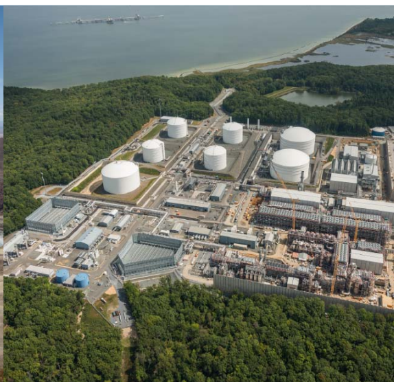
コーブポイントLNG基地（米国）
