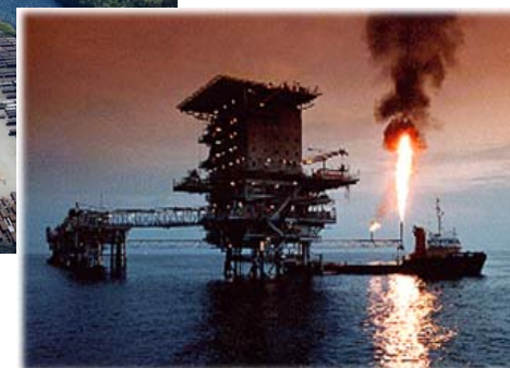
油井管が使用される 海洋油田の開発設備
