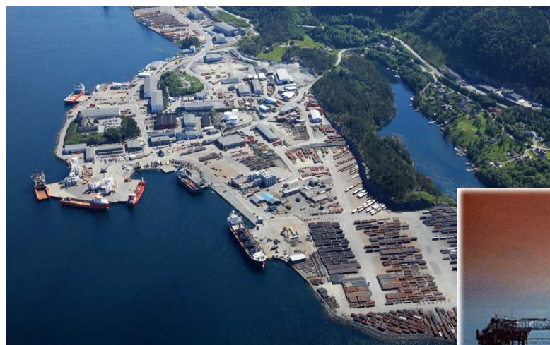
ノルウェーの鋼管在庫ヤード
