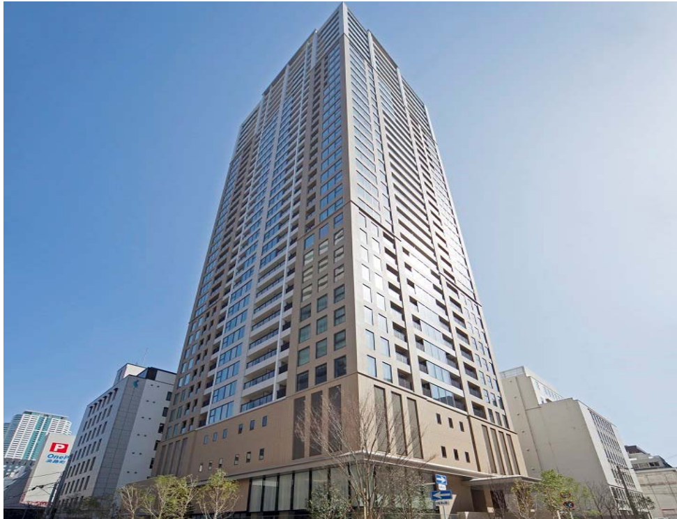
クラッシュタワー 淀屋橋
