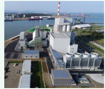
酒田バイオマス発電所(山形県)
