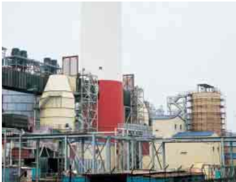
当社が韓国、米国、英国、オーストラリア等のメーカー等とタイアップしてベトナムに建設中の石炭火力発電所。
