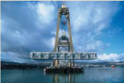
黒海を縦断する海底ガスパイプラインの敷設工事現場
