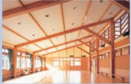
三井住商建材が躯体工事を行った木造校舎（多目的ホール）
