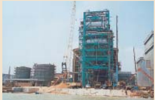
マレーシアにて建設中のPRAI複合火力発電所
