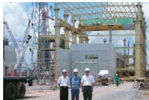
ベトナム初のIPP：急ピッチで建設工事が進むフーミー-2火力発電所の建設現場
