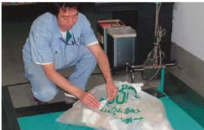
当社晴海本社ビル地下1階に設置されている品目別バーコード・ゴミ計量システム
