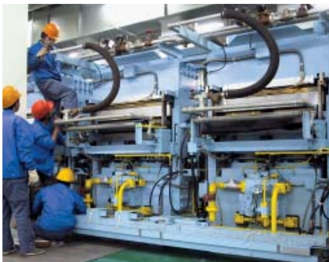
無錫住商高新物流有限公司での設備輸送作業
