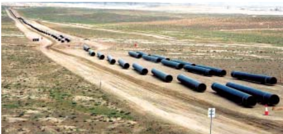
アゼルバイジャンにおけるパイプライン敷設現場
