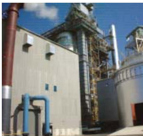
新潟県糸魚川市のバイオマス発電所
