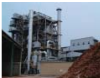
新潟県糸魚川市のバイオマス発電所
