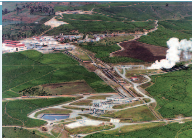
インドネシア独立発電事業者Magma Nusantara Limited向け、ワヤンウィンド地熱発電所。2000年に完工した1号機(110MW)に続き、2007年に2号機(117MW)の建設を受注しました。地熱発電所は、CO 2 発生量が少なく、地球環境保護の面から利点があります。
