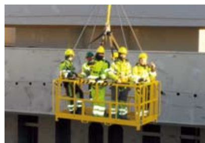
安全保護具と安全ベルトを着用した作業員（ノルウェー・フローロ）
