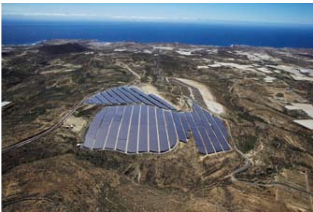
スペイン・テネリフェ島の太陽光発電所
