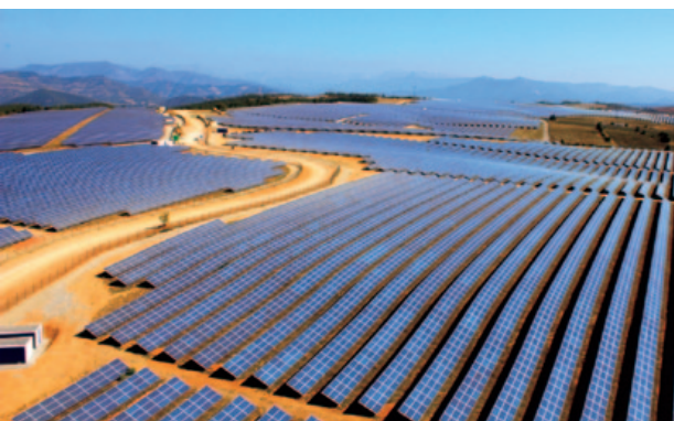
PHOTO A フランス・31MW 太陽光発電所
