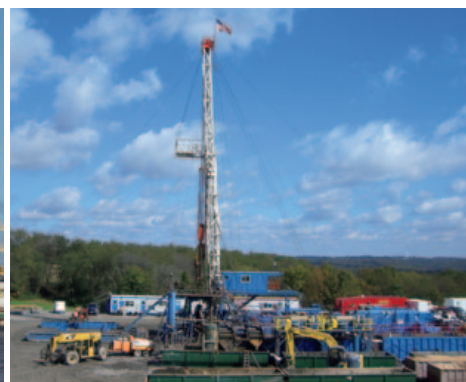
PHOTO B マーセラスシュールエリアの掘削中ランドリグ
