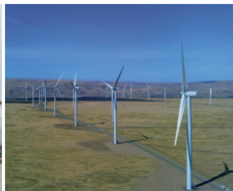
PHOTO B シェファーズフラット風力発電所の風車(米国)
