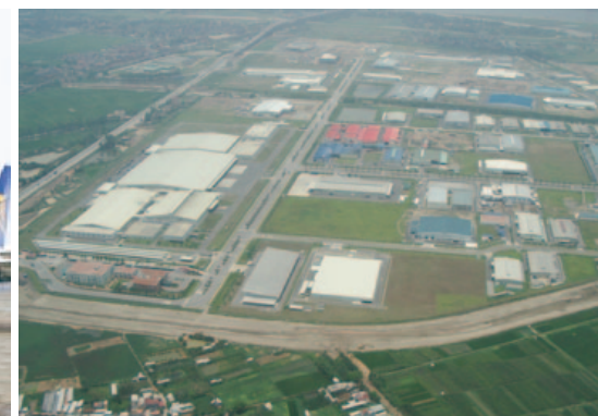
PHOTO C ベトナム・タンロン工業団地
