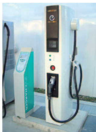
認証課金コントローラー(左側)
