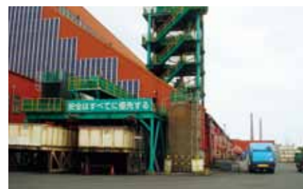
実地確認セミナーを行った処理施設
