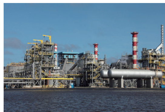
マダガスカル アンバトビー・ニッケルプラント
