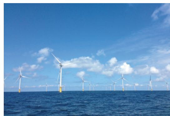
ノースウィンド洋上風力発電所(ベルギー)
