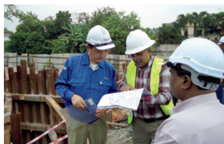
東京都下水道サービス(株)による下水処理場設計支援
