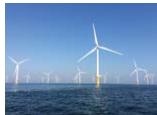
ベルギー洋上風力発電プロジェクト
