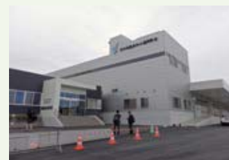
「気仙沼 ししきり 折加工協同組合」事務所及び冷蔵倉庫
