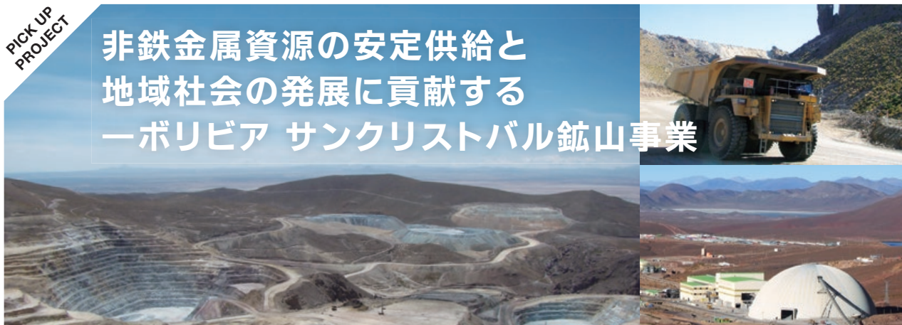
(左) 鉱山全景 (標高約4,000mに位置する露天掘り) (右上) 採掘現場から鉱石を運搬する大型ダンプトラック (右下) 選鉱プラント外観 (手前は粉塵飛散防止ドーム)
