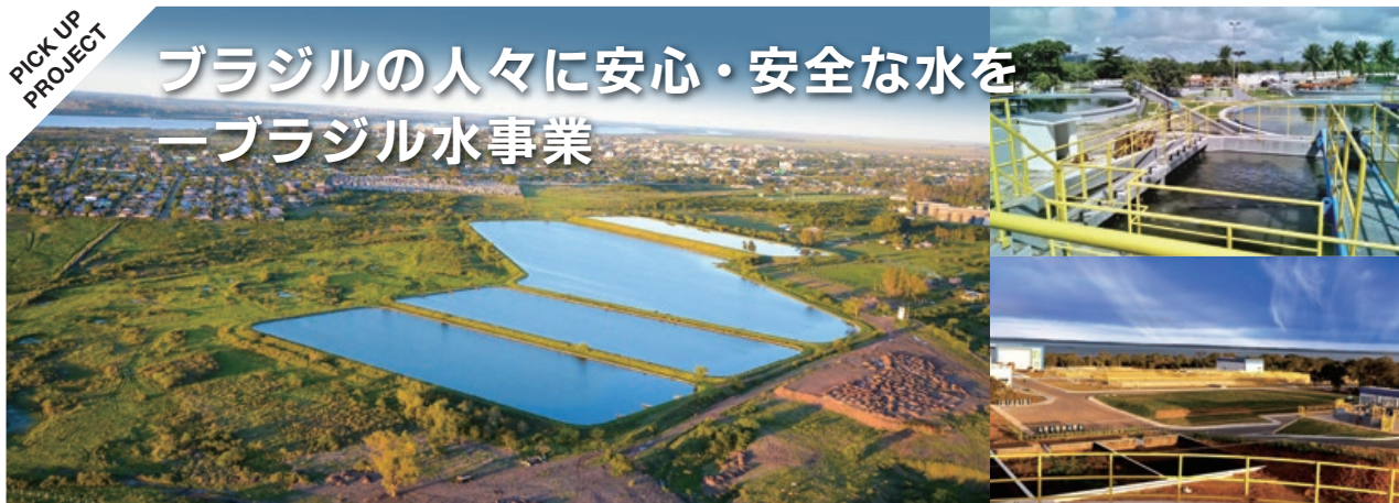
(左) リオグランデ・ド・スル州 下水処理場 (右上) ベルナンブーコ州 下水処理場 (右下) トカンティンス州 下水処理場
