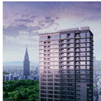
クラッシタワー新宿御苑 （分譲マンション）
