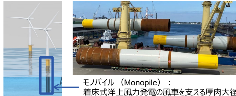
ドイツ北東部ロストックの積み出し港で運搬船に積載されるモノパイル
