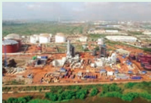
建設中の複合火力発電所（ガーナ）
