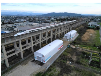
図1：上空からの外観
