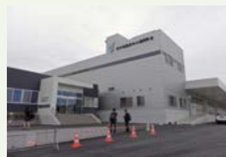
「気仙沼鹿折加工協同組合」事務所及び冷蔵倉庫
