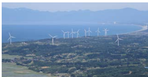
男鹿風力発電所(日本)
