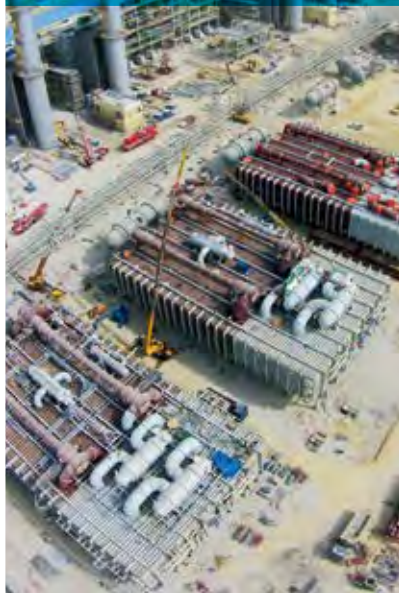
アズール・ノース発電・造水プロジェクト（クウェート）
