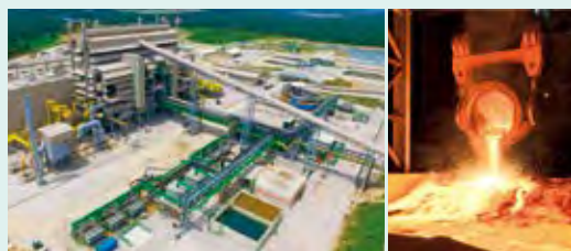
マンガン系合金鉄製造工場 (マレーシア)
