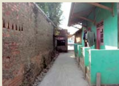
修復された校舎
