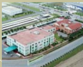
ベトナム ● タンロン工業団地
