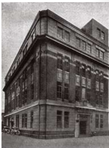
日本建設産業が本拠とした住友ビル分館
