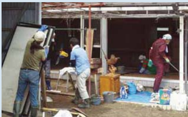
家屋のがれき除去、泥出し
