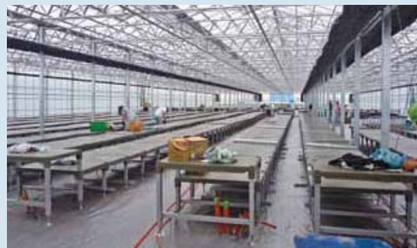
廃プラスチックをリサイクルした架台
