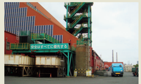
現地確認セミナーを行った処理施設
