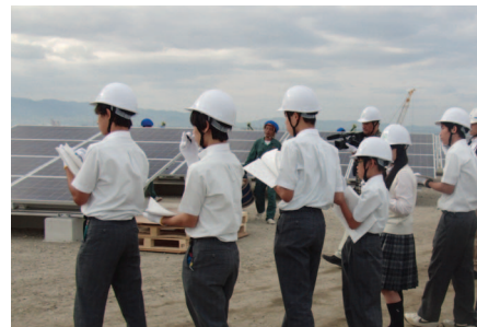
咲くやこの花中学校生徒の建設現場見学の様子
