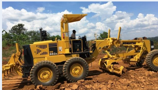
納入した機材で現地オペレーターのトレーニングも行う。 写真は整地に使用されるモーターグレーダー。
