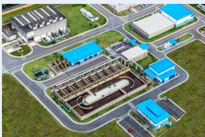
BRK Ambiental社が運営する産業用水処理施設
