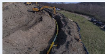
陸上パイプライン敷設現場
