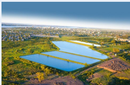
リオグランデ・ド・スル州 下水処理場
