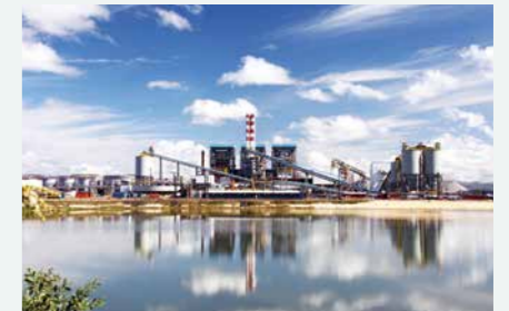
マダガスカル アンバトビー ニッケルプラント
