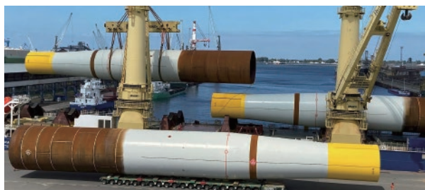
洋上風力発電用の基礎構造物(モノパイル)
