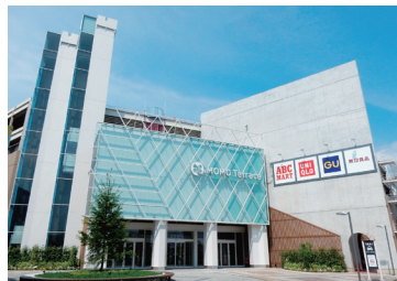
MOMOテラス (京都府京都市伏見区)
