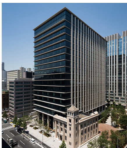
■テラススクエア全体外観
