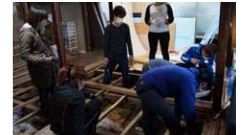
改修中の様子(写真：団体提供)
