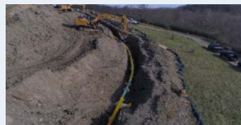
陸上パイプライン敷設現場
